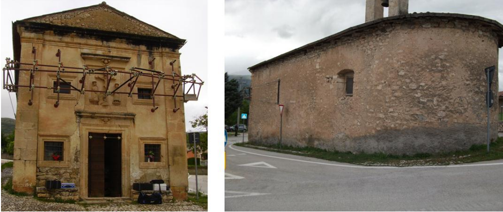
Fig 7. The Visitazione church: external views
